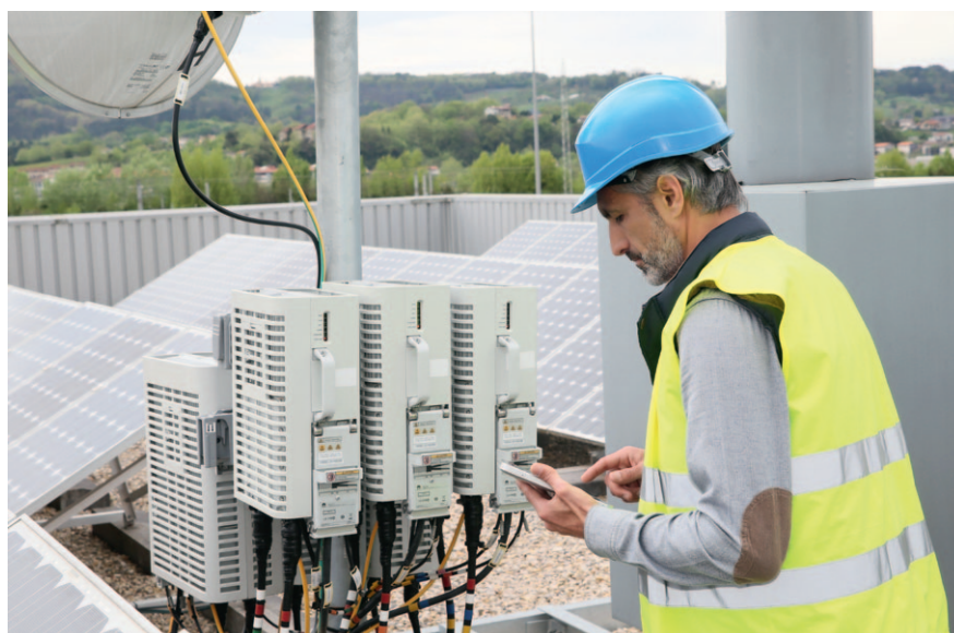
Bild 3 Richtig eingesetzt, können digitale Lösungen die Effizienz von Monteuren steigern.
