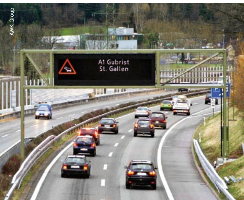
Wechseltextanzeige auf der Nationalstrasse: Sie wird künftig über die neue Fachapplikation ab der VMZ-CH in Emmenbrücke angesteuert.
